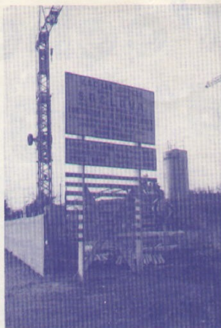
Aux Justices, une première tranche de logements H.L.M. sort de terre.
